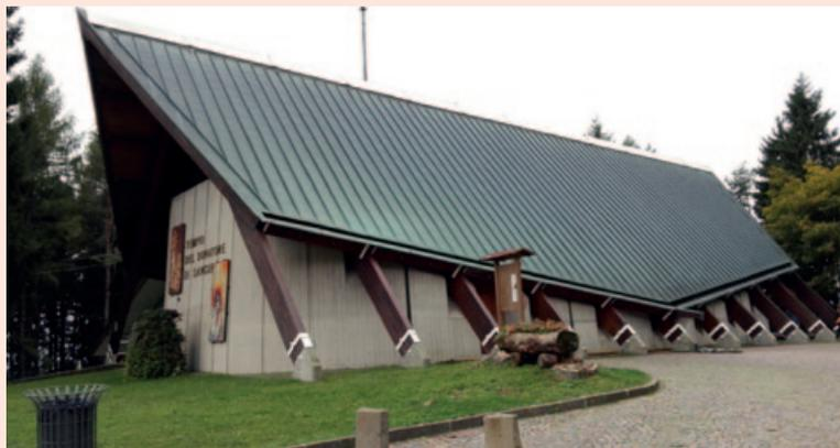
*Il lato nord del Tempio: in evidenza la struttura lignea che supporta la copertura della Chiesa.*
